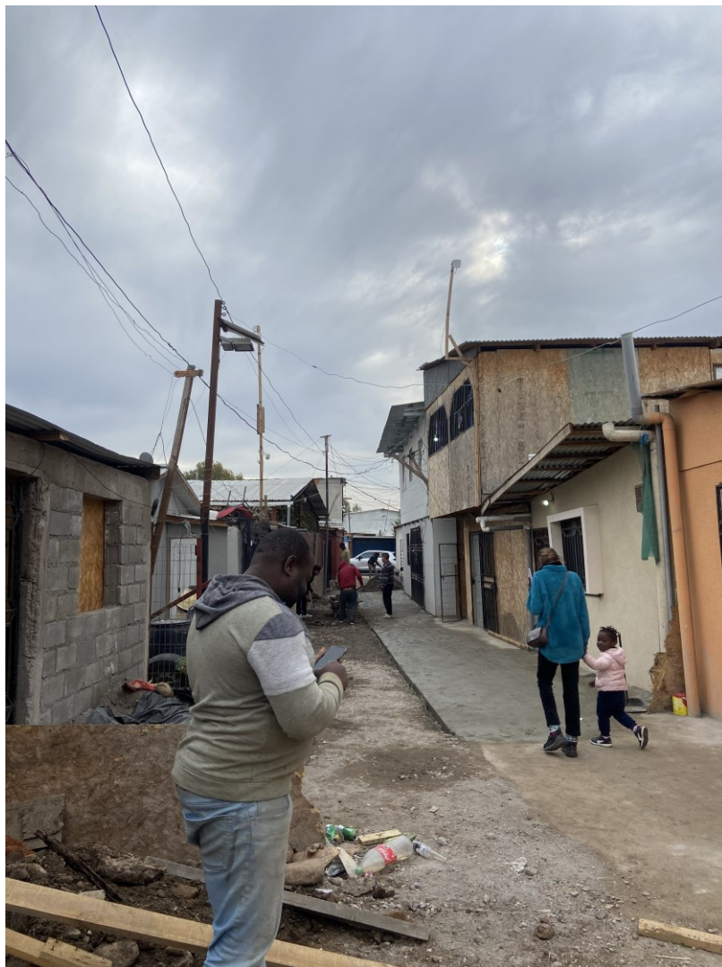
Figura 2. Comparación del proceso de avance entre mayo y septiembre de 2024 en la pavimentación colectiva en una calle de Un Nuevo Amanecer (Fuente: fotografía tomada por Miguel Pérez).
