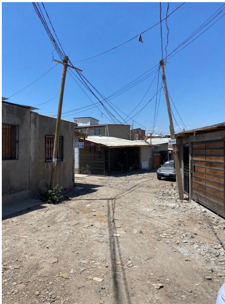
Figura 1. Ausencia de arbolado urbano y presencia de conexiones irregulares al tendido eléctrico (Fuente: foto tomada por Miguel Pérez en enero de 2024).
